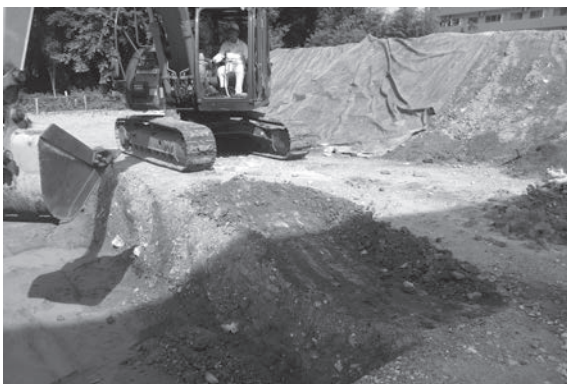
7 北拡張区重機掘削（東から）
