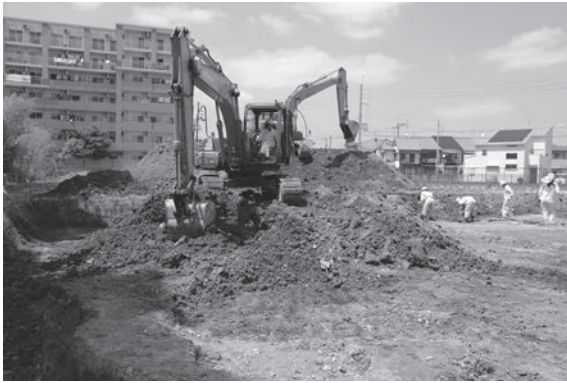
1 重機掘削（南から）
