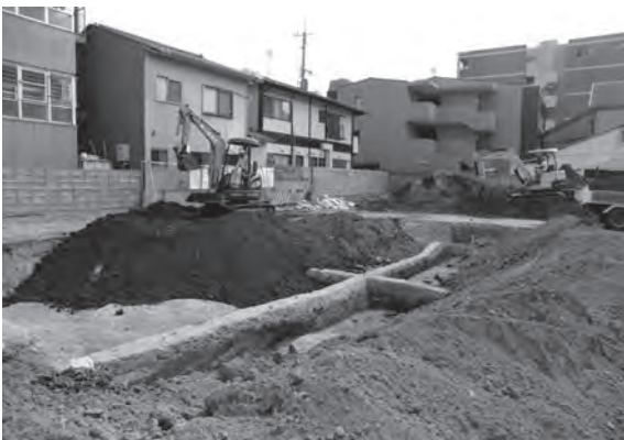
7. 埋め戻し作業（南西から）
