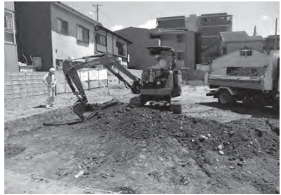
2. 重機掘削作業（西から）
