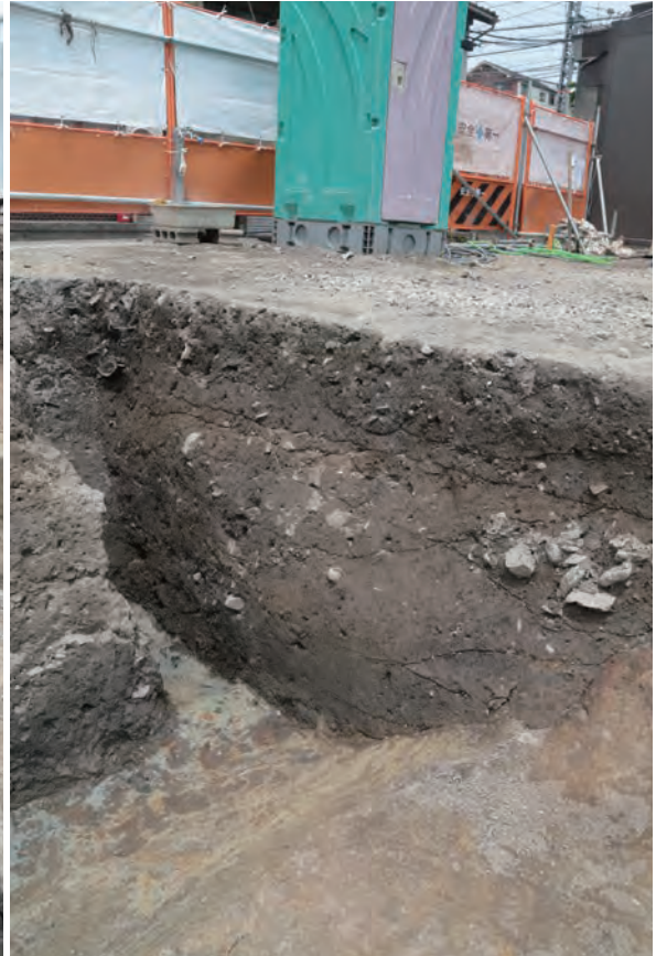
3. 溝110断面（北壁 南東から）
