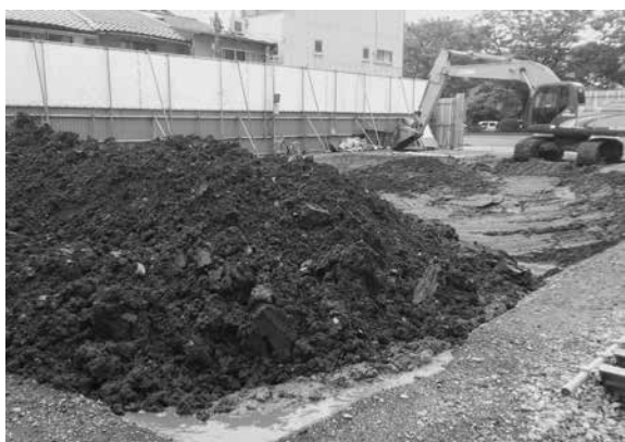
7.埋戻し作業（北東から）
