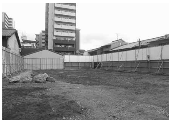
8.調査完了後（北西から）
