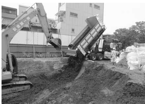
6.残土搬入作業（北東から）
