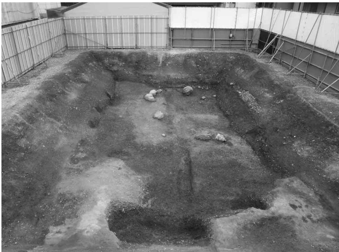
2. 第3面完掘状況（西から）
