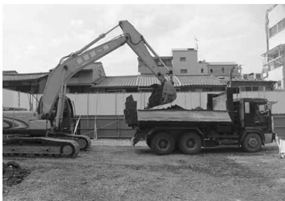
3.掘削土搬出作業（北から）
