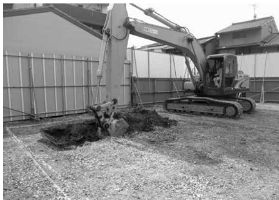
2.重機掘削（北西から）
