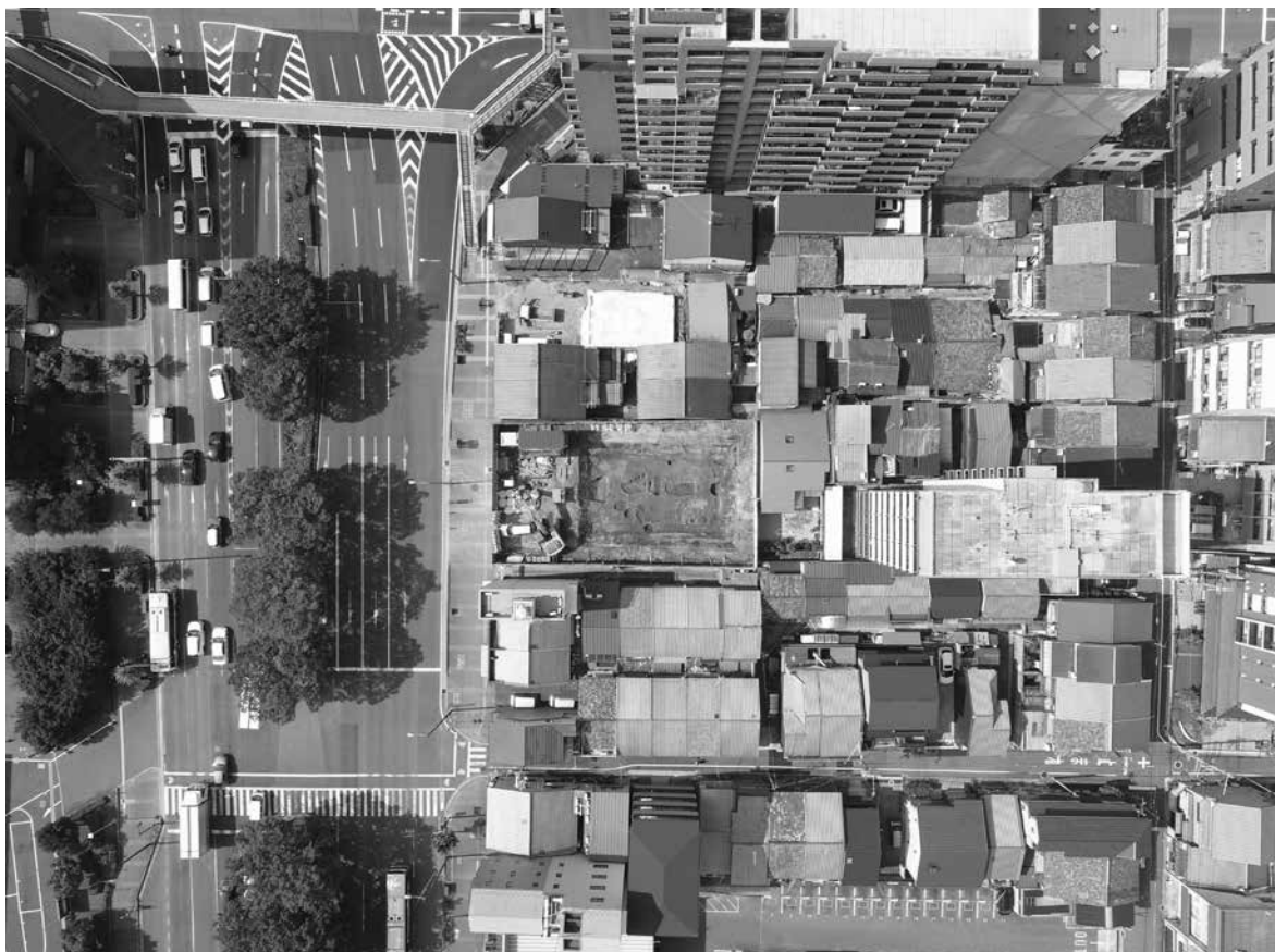
1. 調査地全景（上が北）
