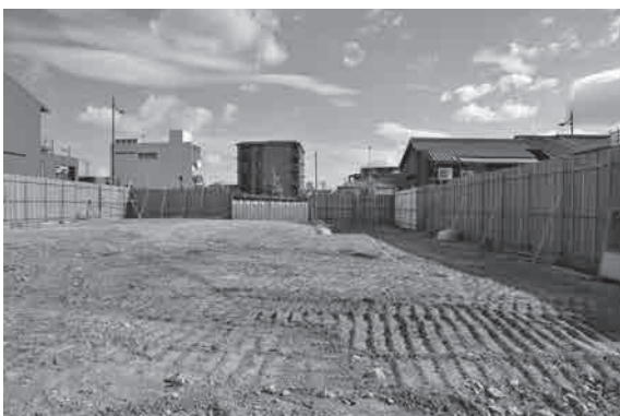
7. 埋戻し終了後（北から）
