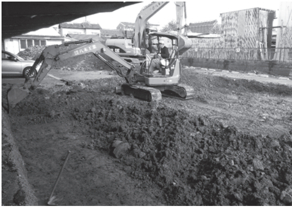
3. 重機掘削 (南西から)
