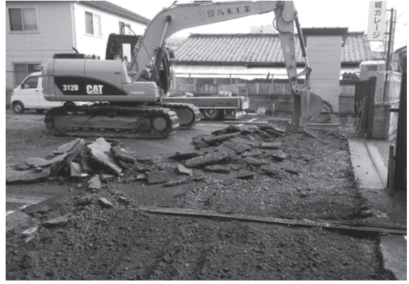
2. アスファルト撤去 (西から)
