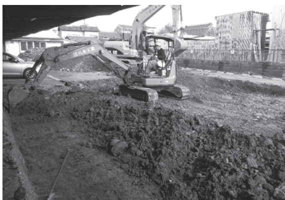
3. 重機掘削（南西から）
