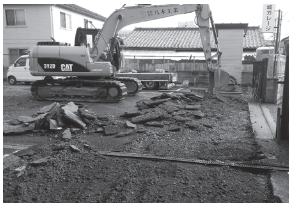
2. アスファルト撤去（西から）
