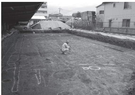
7. TS測量作業（南西から）
