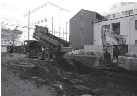
7. 埋め戻し作業（南東から）
