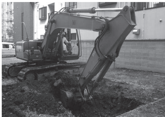
2. 重機掘削作業（東から）
