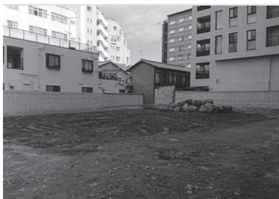
8. 調査完了後（南西から）
