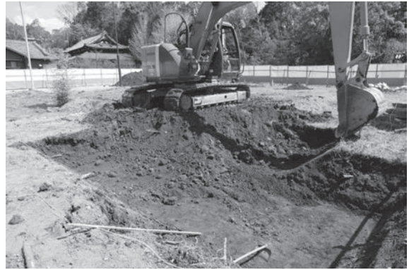
2. 重機掘削（南西から）
