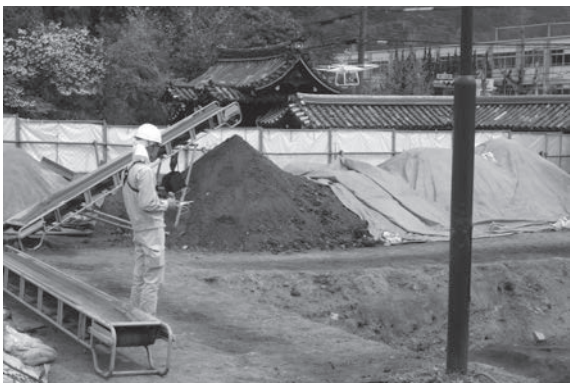
5. ドローン測量風景（北西から）
