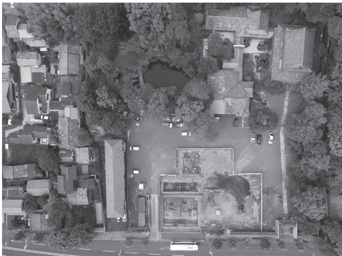
1. 調査地全景（上が北）
