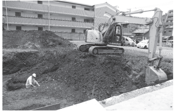
2. 重機掘削 (北東から)
