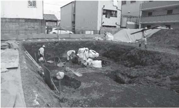
3. 1区作業風景 (北西から)
