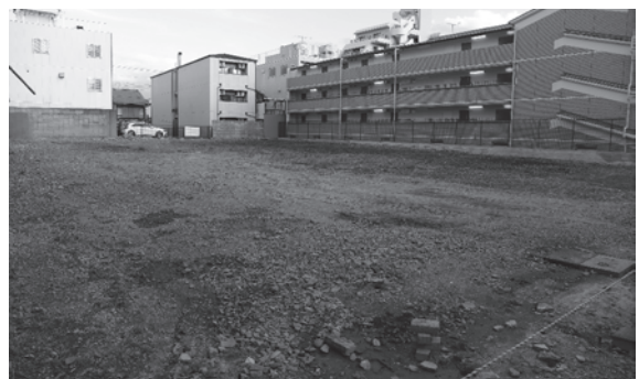
8. 調査完了後 (北西から)
