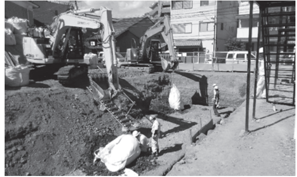
4. 1区埋戻し (北東から)
