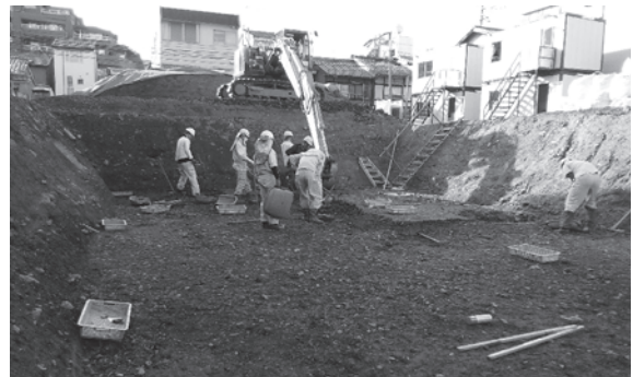
6. 3区作業風景 (北東から)
