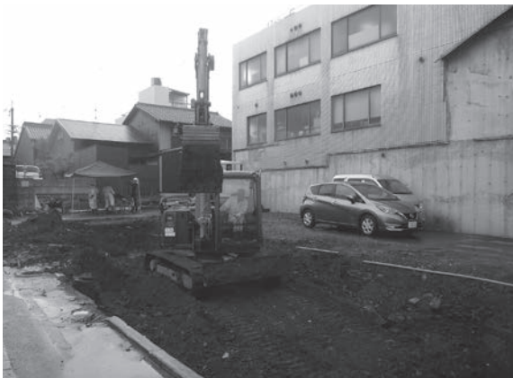
7. 埋戻しと転圧作業
