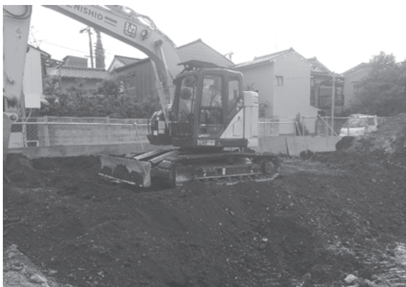
7. 埋め戻し作業（北西から）
