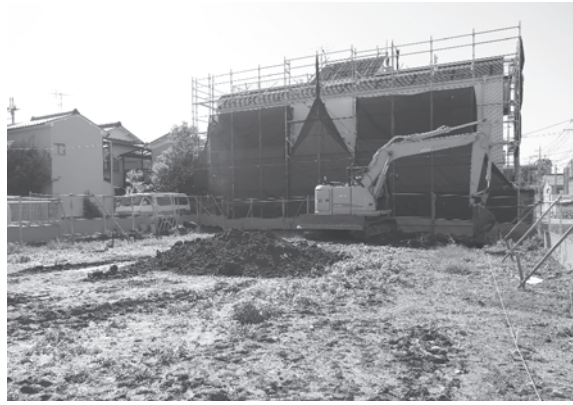
2. 重機掘削作業（北西から）
