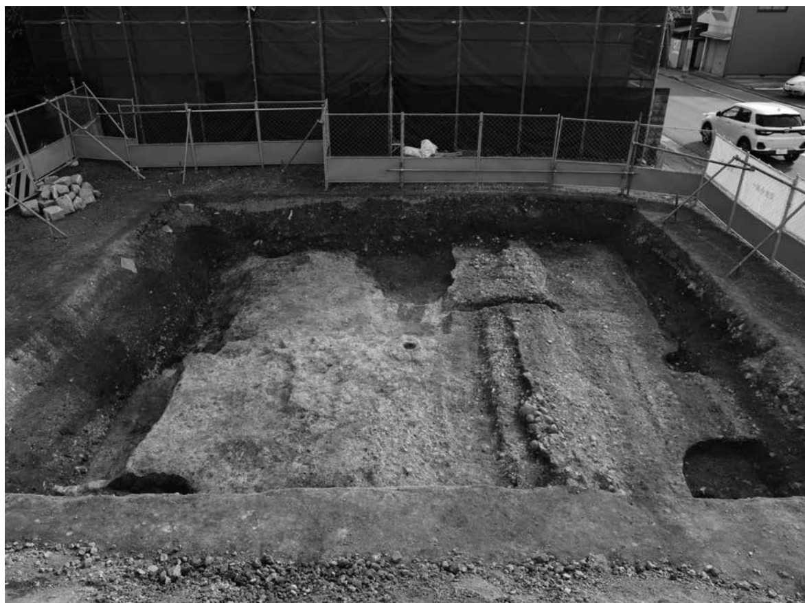
1. 南区 第2面調査区全景（北から）
