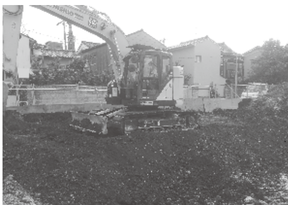
7. 埋め戻し作業（北西から）
