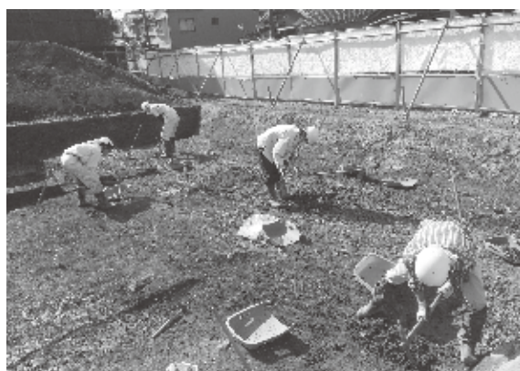
6. 北区第1面遺構掘削作業（北東から）
