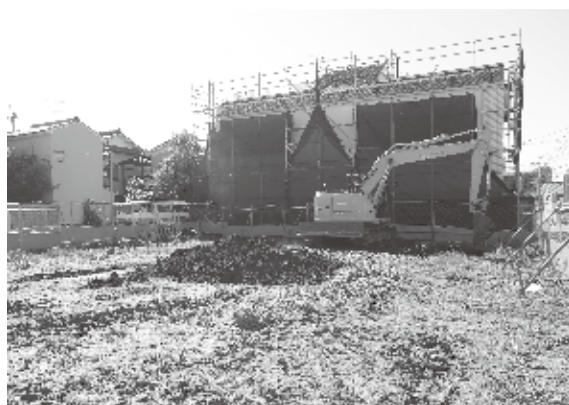
2. 重機掘削作業（北西から）
