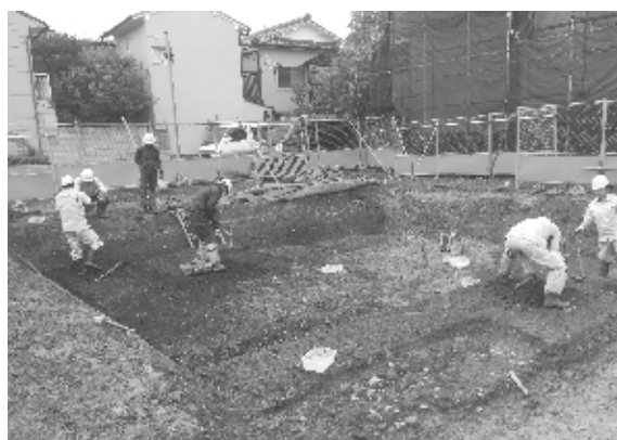
4. 南区層間掘削作業（北西から）
