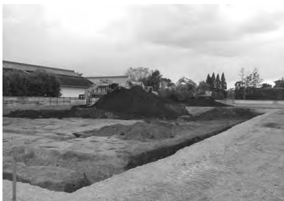
7. 埋め戻し作業（北東から）
