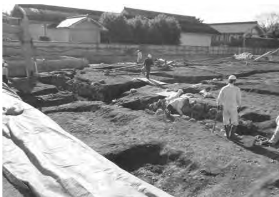
3. 禁裏御用水掘削作業（北東から）
