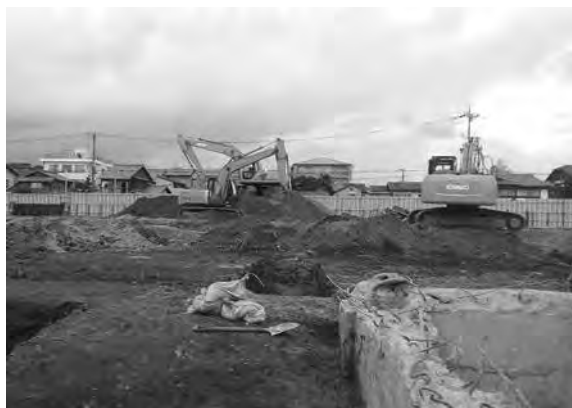
2. 重機掘削作業（南から）
