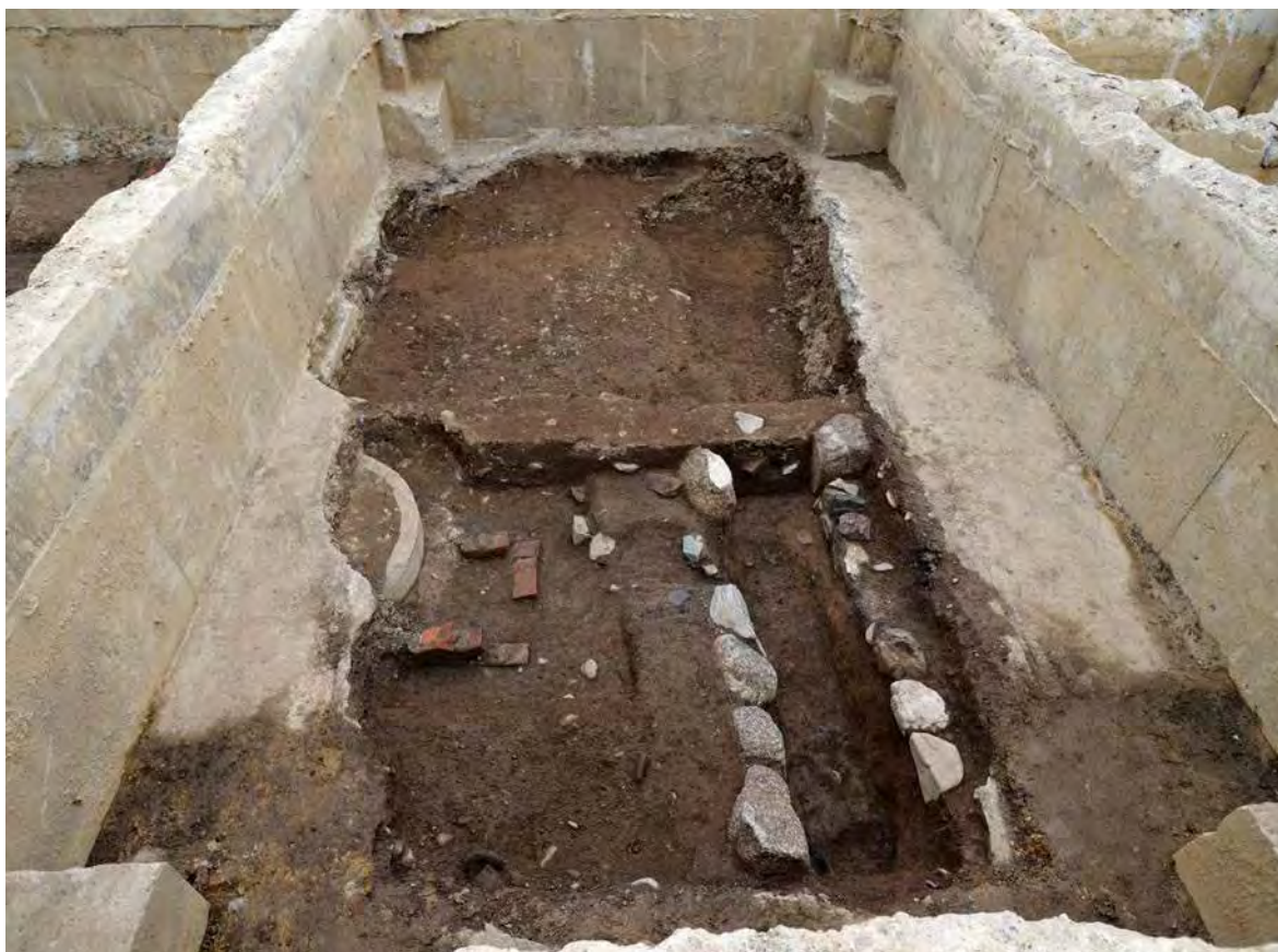
2. 第2-1面 地中梁D内溝0124掘削後状況（南から）
