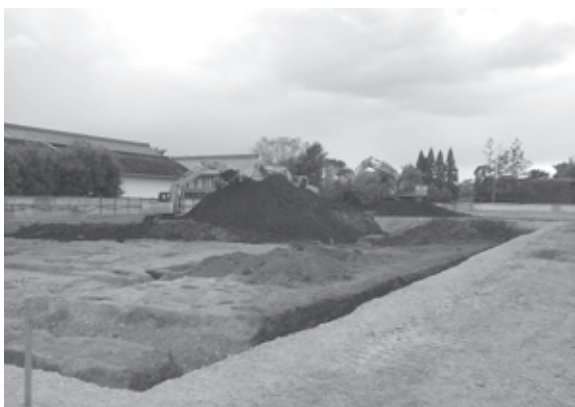
7.埋め戻し作業（北東から）
