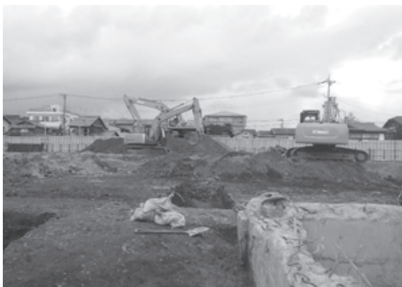
2.重機掘削作業（南から）
