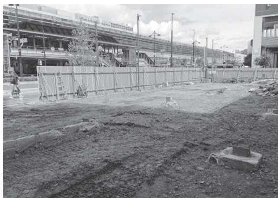
8. 調査完了後（南西から）
