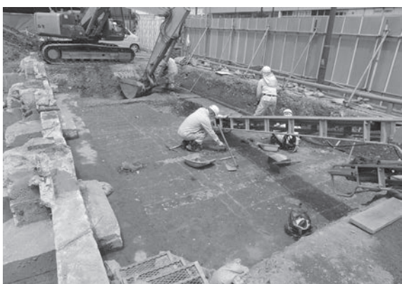
3. 東区調査経過 1（南東から）
