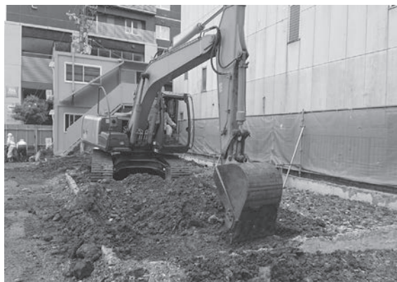
2. 重機掘削作業（西から）
