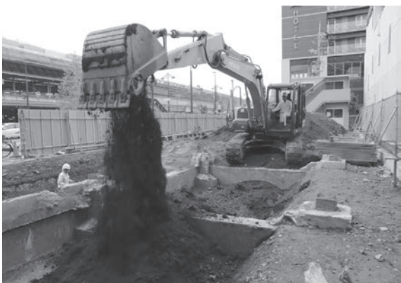
7. 埋め戻し作業（南西から）
