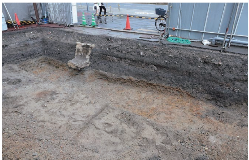
3. 流路280 西區北壁付近掘削後の状況（南東から）
