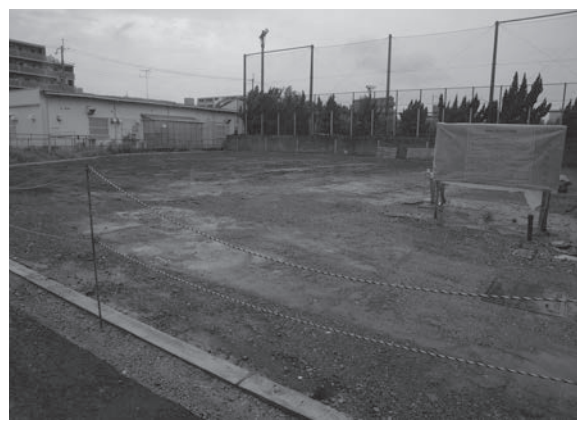
8. 埋戻し終了後（南東から）
