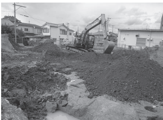
7. 重機による埋戻し作業
