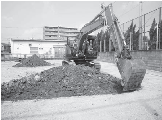
3. 重機掘削作業
