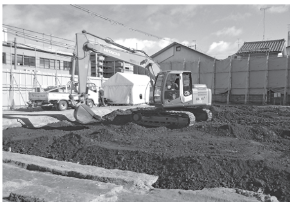
7. 埋め戻し作業（南西から）
