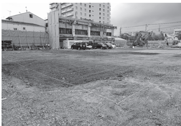
1. 調査着手前（北東から）
