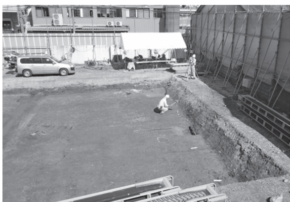
3. 東区グリッド杭打設作業（南から）
