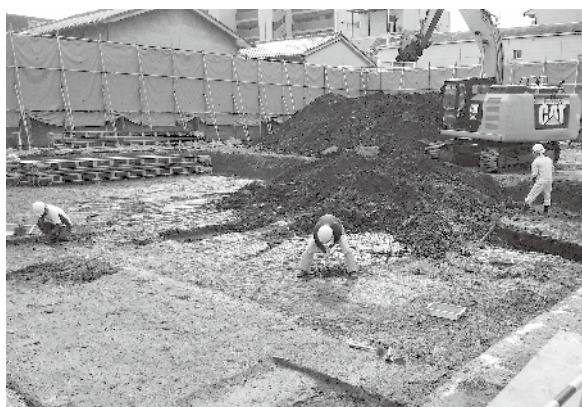
2. 重機掘削作業（北西から）
