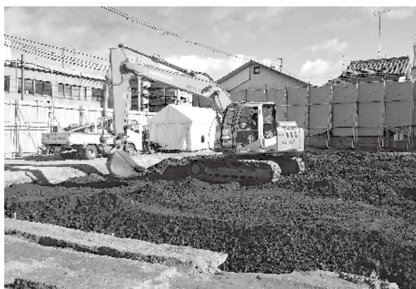
7. 埋め戻し作業（南西から）
