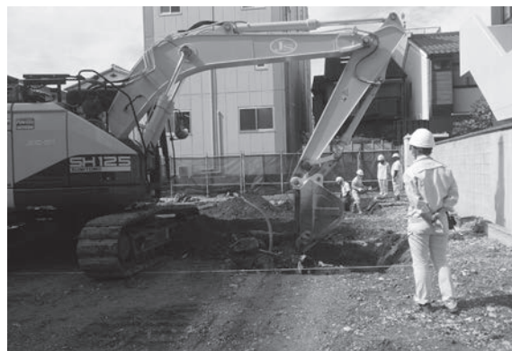
2. 重機掘削作業（東から）
