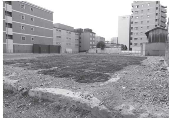
8. 北区調査完了後（北西から）
