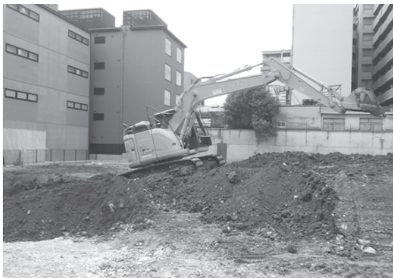
7. 南区埋め戻し作業（北から）
