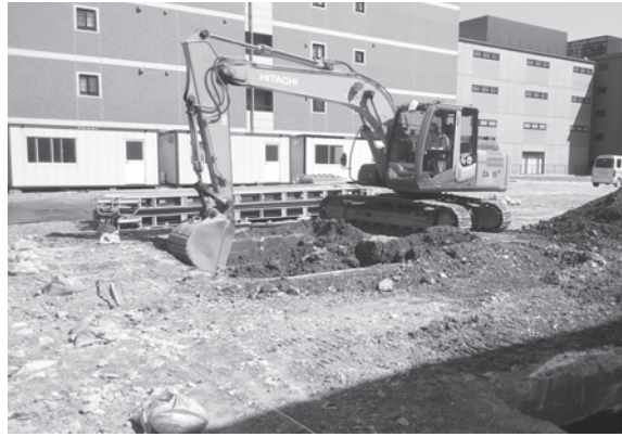
2. 北区重機掘削作業（北西から）
