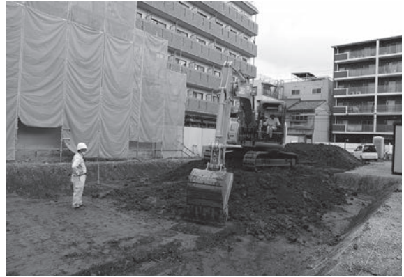
2. 重機による盛土掘削作業
