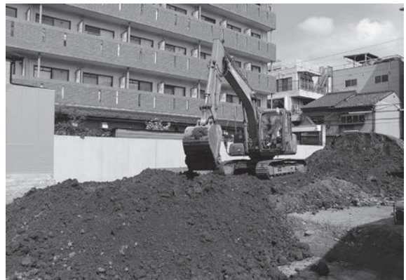
8. 重機による埋戻し作業
