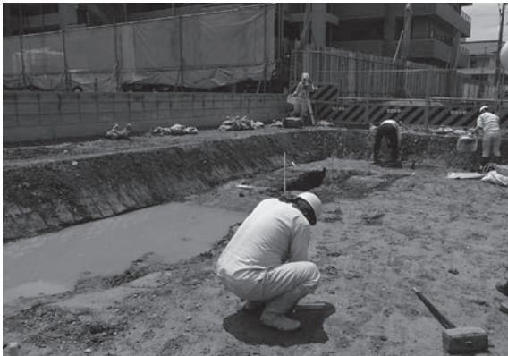
3. グリッド杭設置作業
