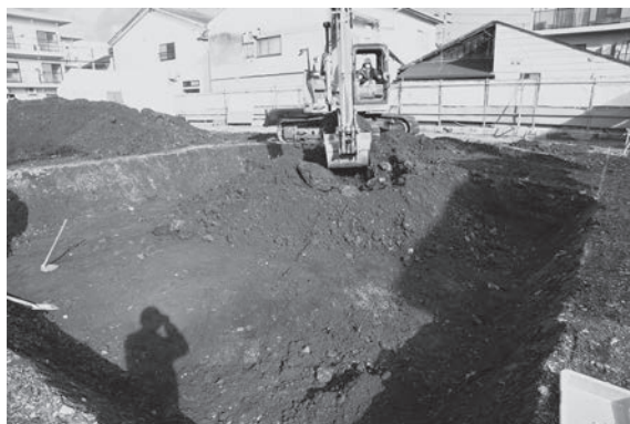
2. 重機掘削作業（南西から）
