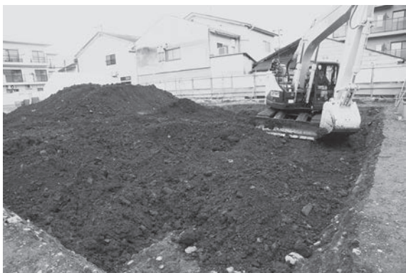
7. 埋め戻し作業（南西から）
