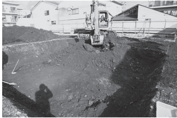
2. 重機掘削作業（南西から）
