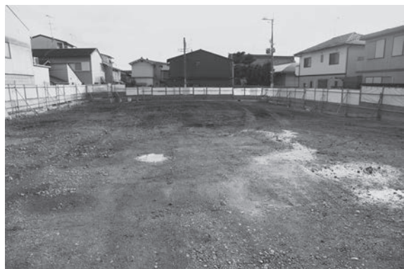
8. 調査完了後（北から）
