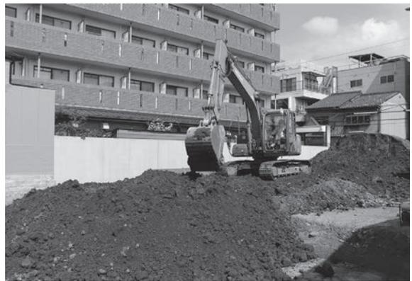
8. 重機による埋戻し作業
