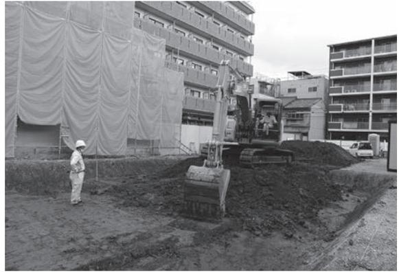
2. 重機による盛土掘削作業
