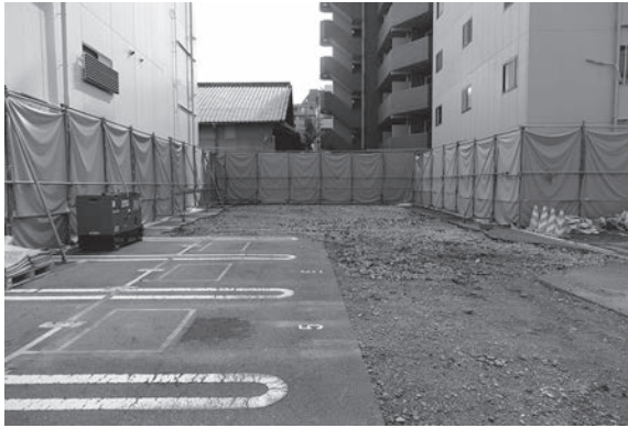
1. 調査前（西から）
