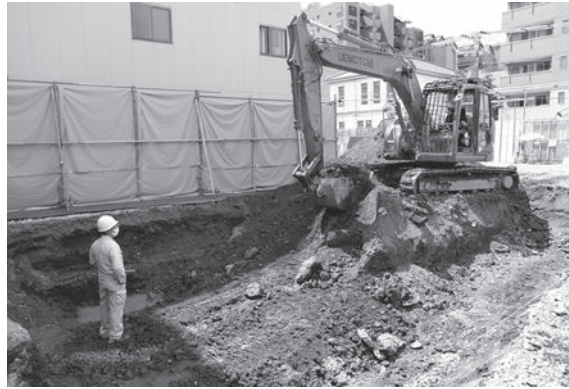
2. 重機掘削（北東から）
