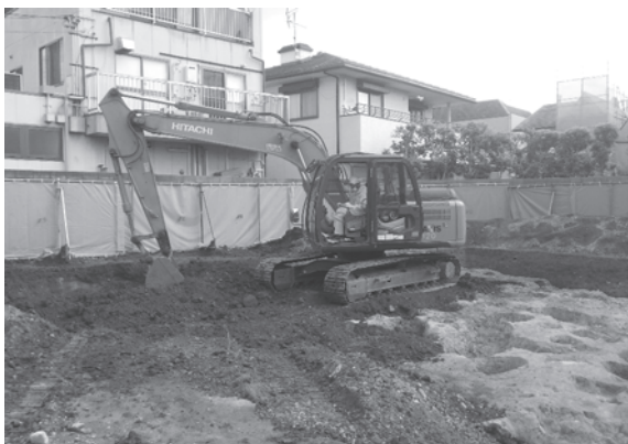
7. 埋め戻し作業（南西から）
