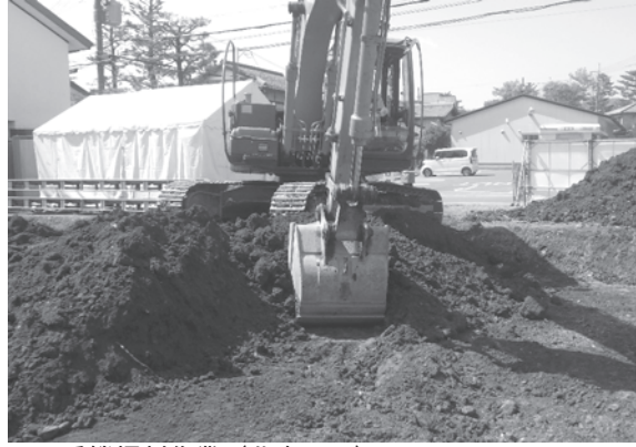
2. 重機掘削作業（北東から）
