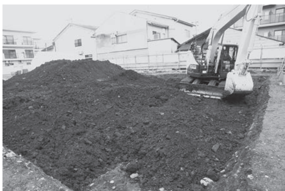
7. 埋め戻し作業（南西から）
