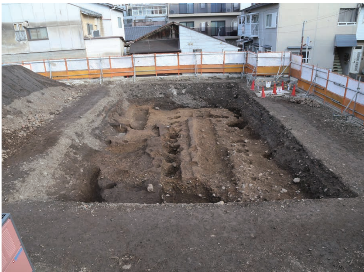
1. 第2面完掘状況（西から）
