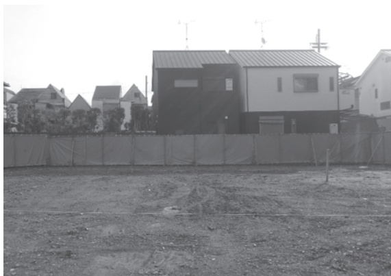
1. 調査前（西から）
