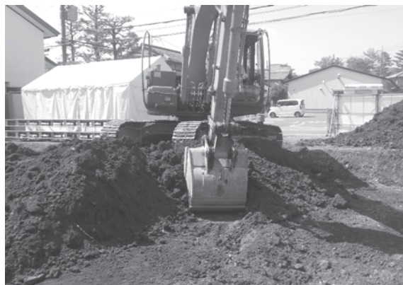
2. 重機掘削作業（北東から）
