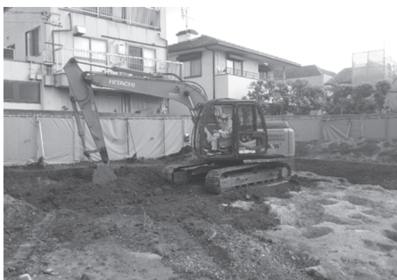
7. 埋め戻し作業（南西から）
