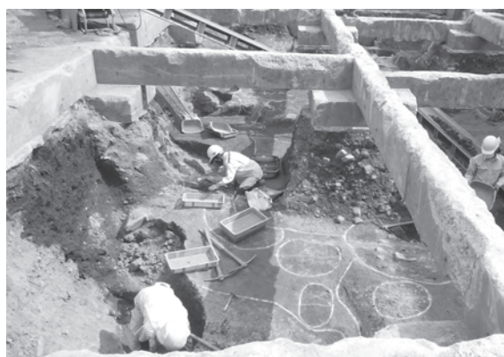
4. 北区第3面遺構掘削作業（北から）
