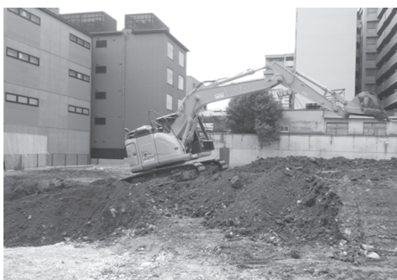
7. 南区埋め戻し作業（北から）
