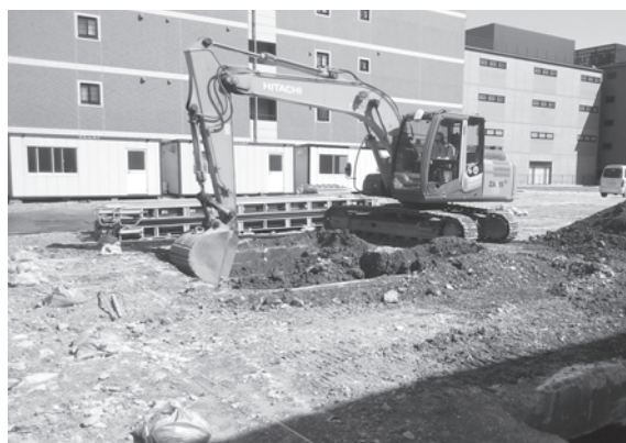
2. 北区重機掘削作業（北西から）
