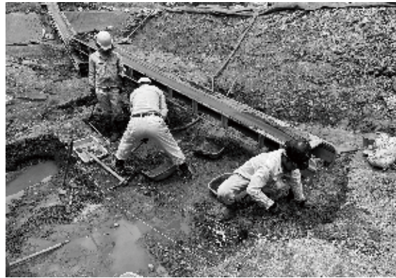
4. 流路001掘削作業（南東から）
