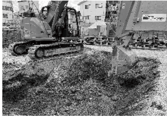
2. 調査区東側重機掘削作業（南東から）
