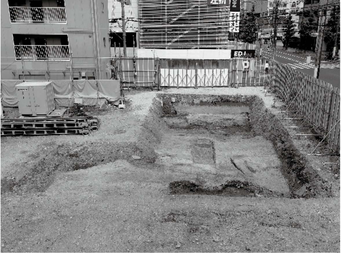
1. 遺構検出後 調査区全景（西から）
