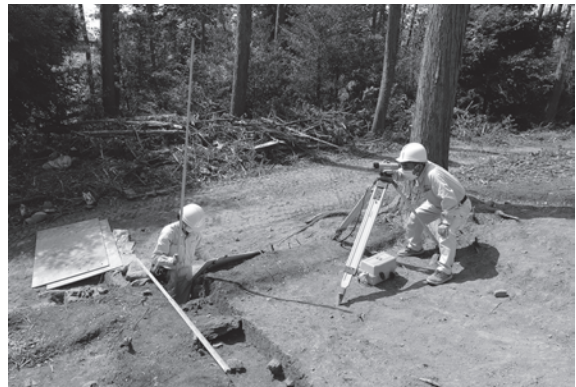
6. B-6号墳石室内断面実測 (北東から)
