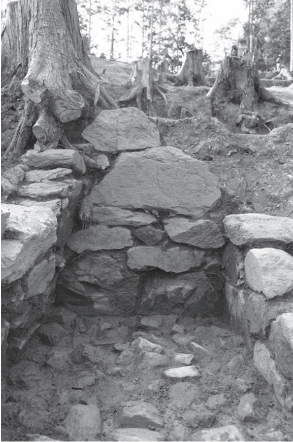
1. B-4号墳 石室奥壁構築状況（南東から）
