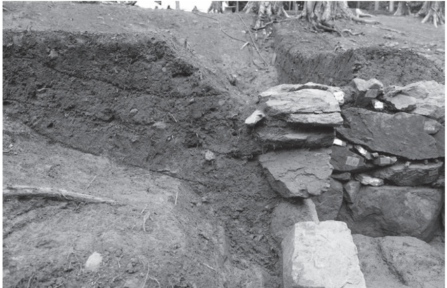
2. B-6号墳 石室右側壁背面セクション断面（南東から）
