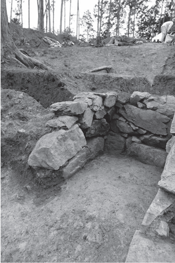
1. B-6号墳 石室右側壁構築状況（南東から）
