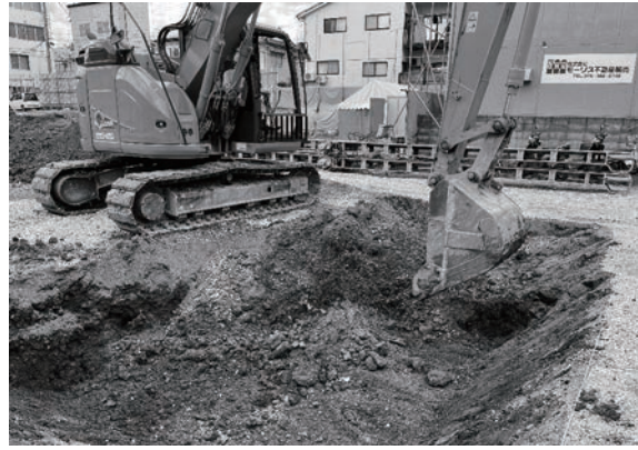
2. 調査区東側重機掘削作業（南東から）
