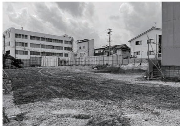
8. 調査完了後（南東から）
