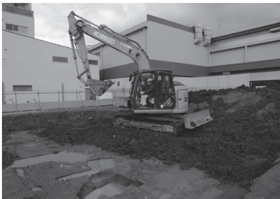
7. 埋め戻し作業（南東から）
