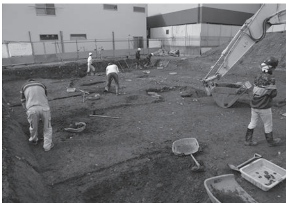
5. 2区遺構掘削作業（南東から）
