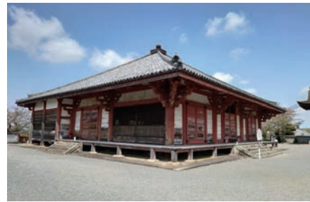
図35 浄土寺浄土堂 (執筆者撮影)
