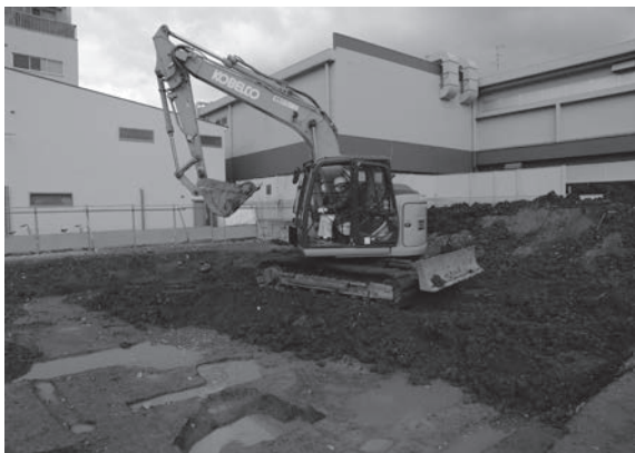
7. 埋め戻し作業（南東から）
