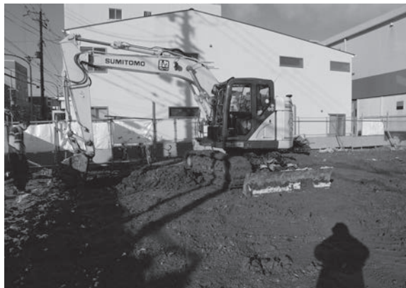
4. 2区重機掘削作業（東から）
