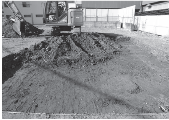
2. 1区重機掘削作業（東から）
