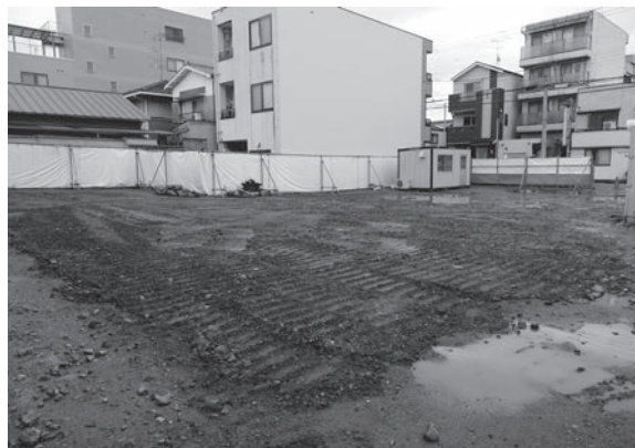
8. 調査完了後（北西から）
