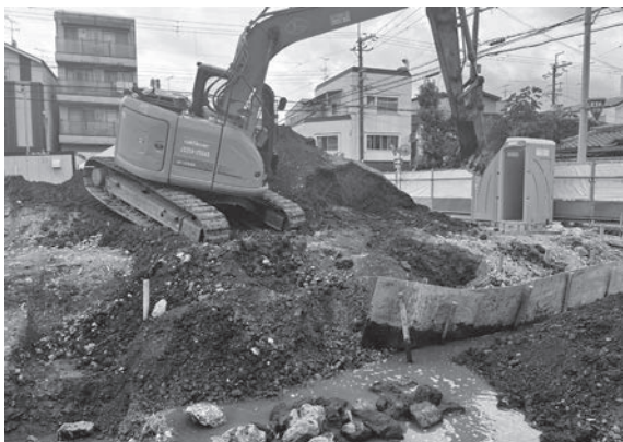
7. 調査区内埋め戻し作業（北東から）
