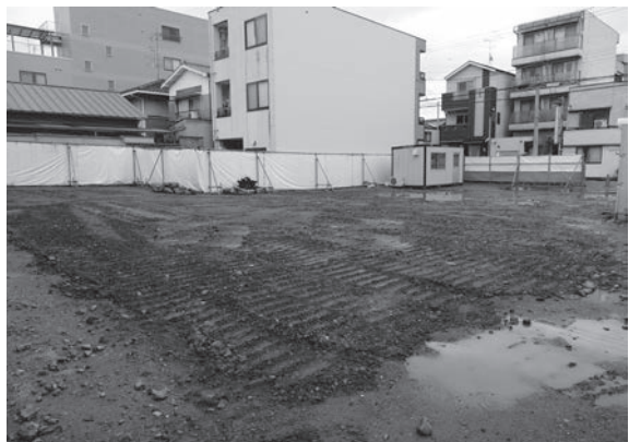
8. 調査完了後（北西から）
