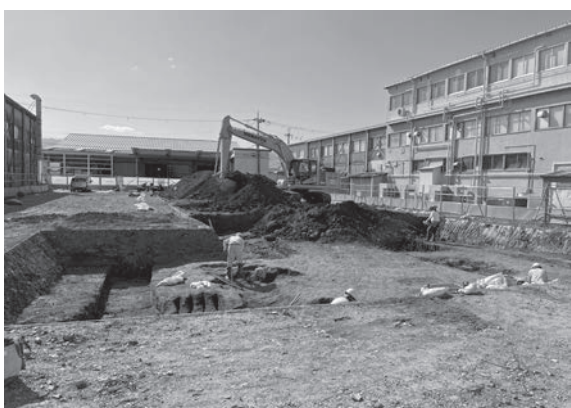
3. 東区重機掘削作業（南東から）
