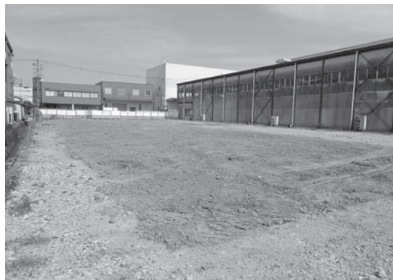
8. 調査完了後（北西から）
