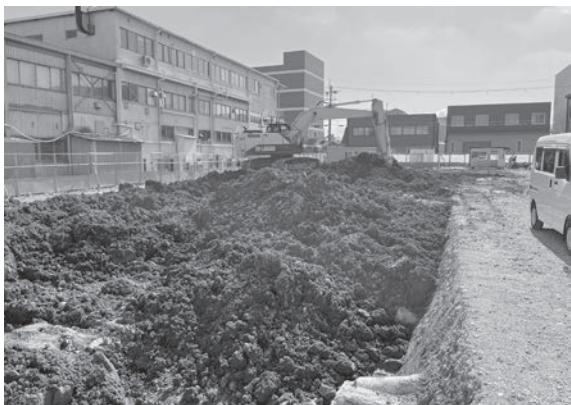
7. 西区埋め戻し作業（南西から）
