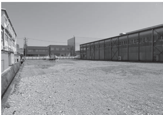
1. 調査前（北西から）
