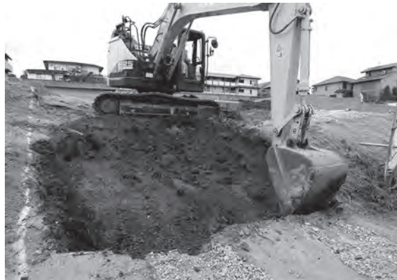
4. 2区表土掘削作業（西から）
