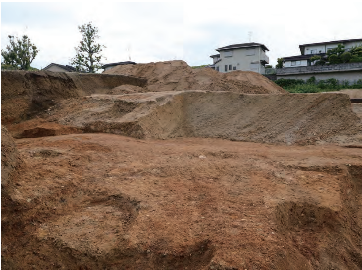
1. 2区北部（郭D）第1段階造成土上面の状況（南西から）
