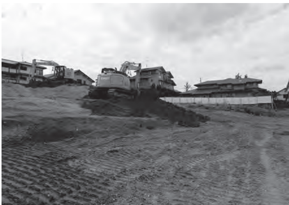
7. 2区埋戻し作業（北から）
