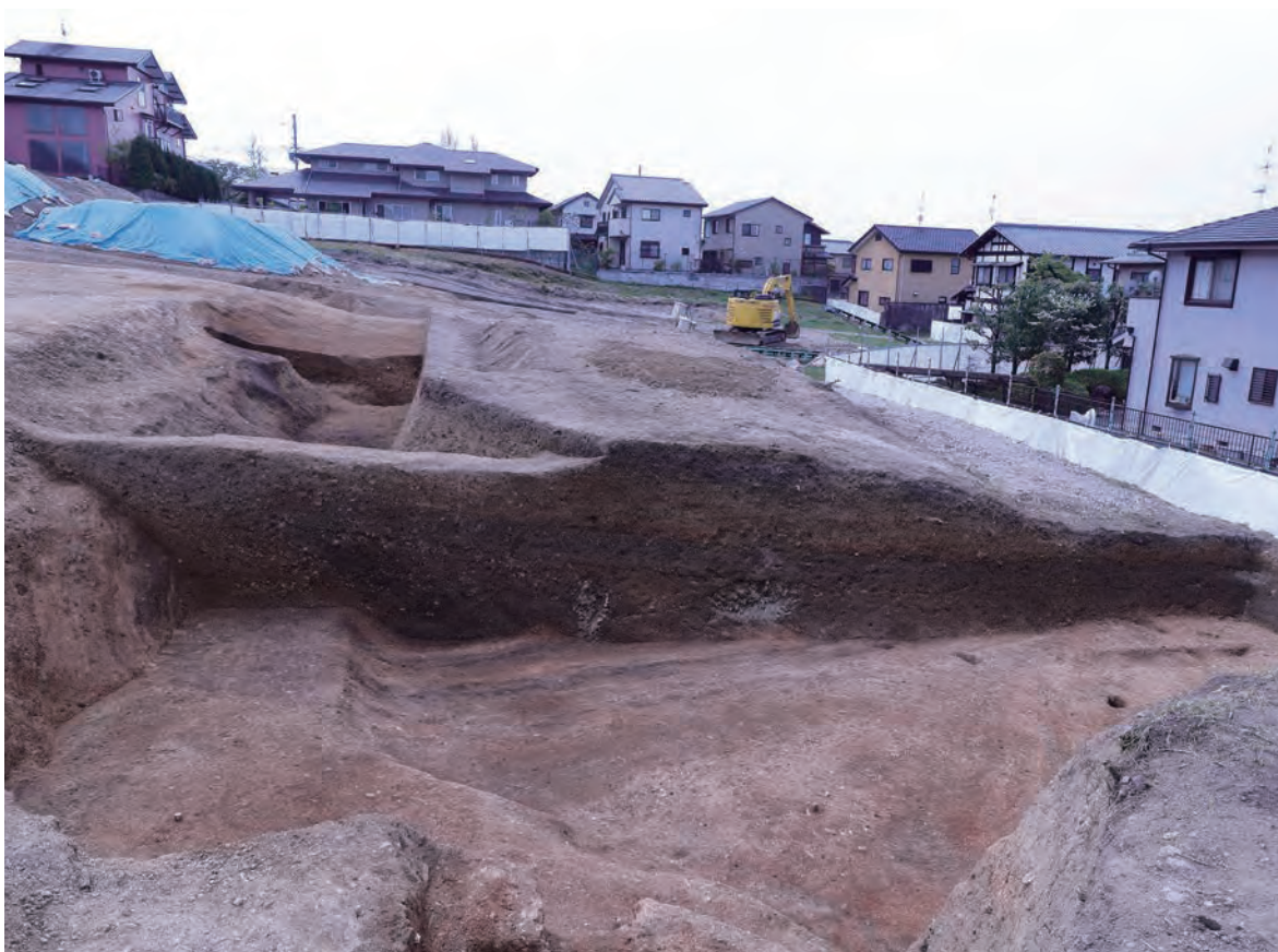
2. 2区北西部（郭I）東西セクション（北から）
