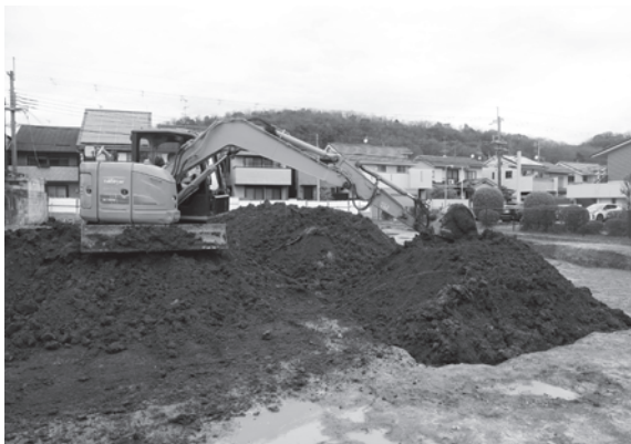
7. 埋め戻し作業（南から）
