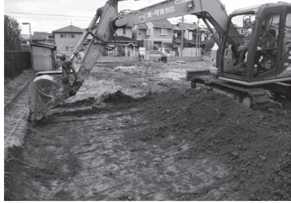
2. 重機掘削作業（北から）
