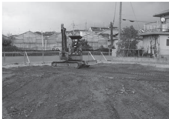
8. 埋め戻し完了（南から）
