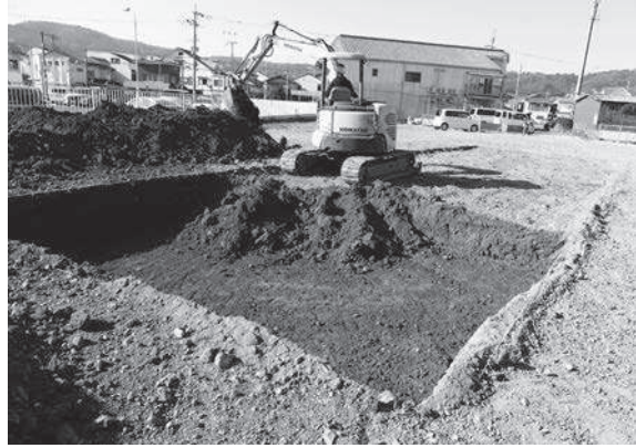
2. 重機掘削（東から）
