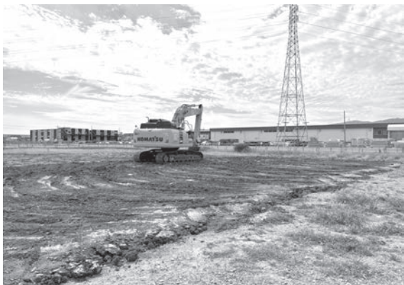
7. 調査区内埋戻し作業（北東から）
