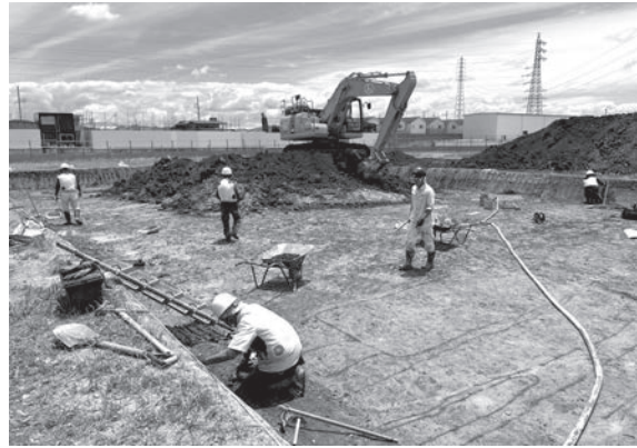
2. 西区重機掘削作業・中世遺構検出作業（北西から）
