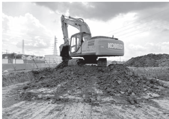
4. 東区重機掘削作業（北から）
