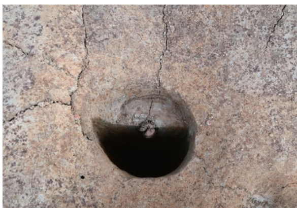
4. 西区 柱穴032 東西断面（北から）
