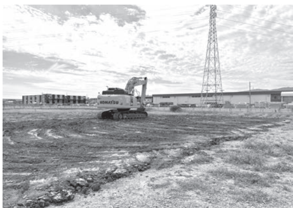
7. 調査区内埋戻し作業（北東から）
