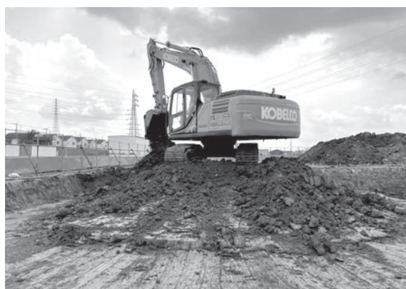
4. 東区重機掘削作業（北から）
