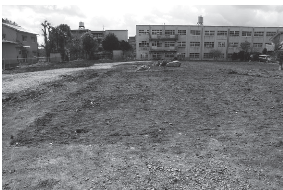
8. 調査完了状況（北から）
