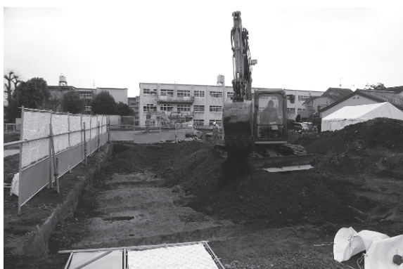
7. 埋め戻し作業（北から）
