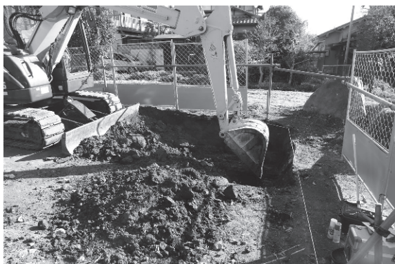
3. 重機掘削作業（西から）
