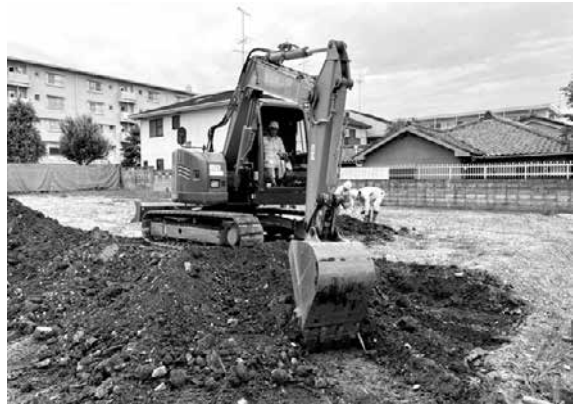
2. 重機掘削作業（北東から）
