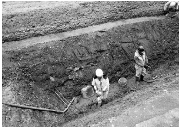
4. 堀埋土断割り後壁面清掃作業（南東から）
