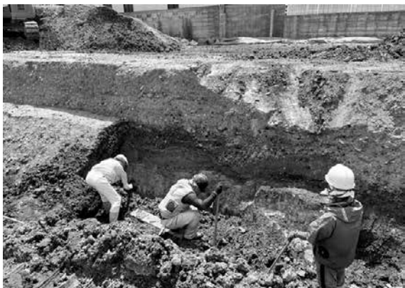
5. 堀接合部調査状況（北東から）
